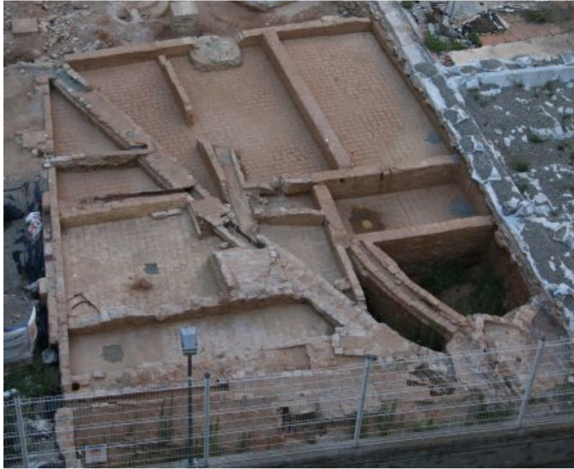
Àrea del pati de la casa-fàbrica de Tarrés dedicat a la decantació de les argiles.
